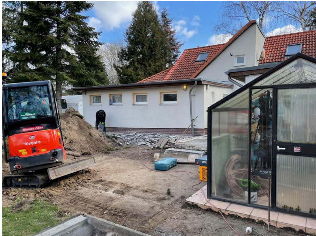
Bauarbeiten auf der hinteren Seite des Vereinsgeländes
